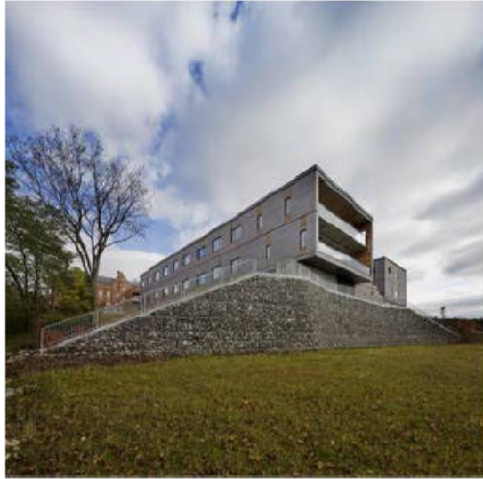
Unité de vie des Filles de la Charité du Sacré-Coeur-de-Jésus, acdf architecture Photo: Marc Cramer
